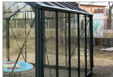
Боковая вентиляция отсутствует
